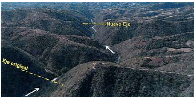
PRESA PASO ANCHO
